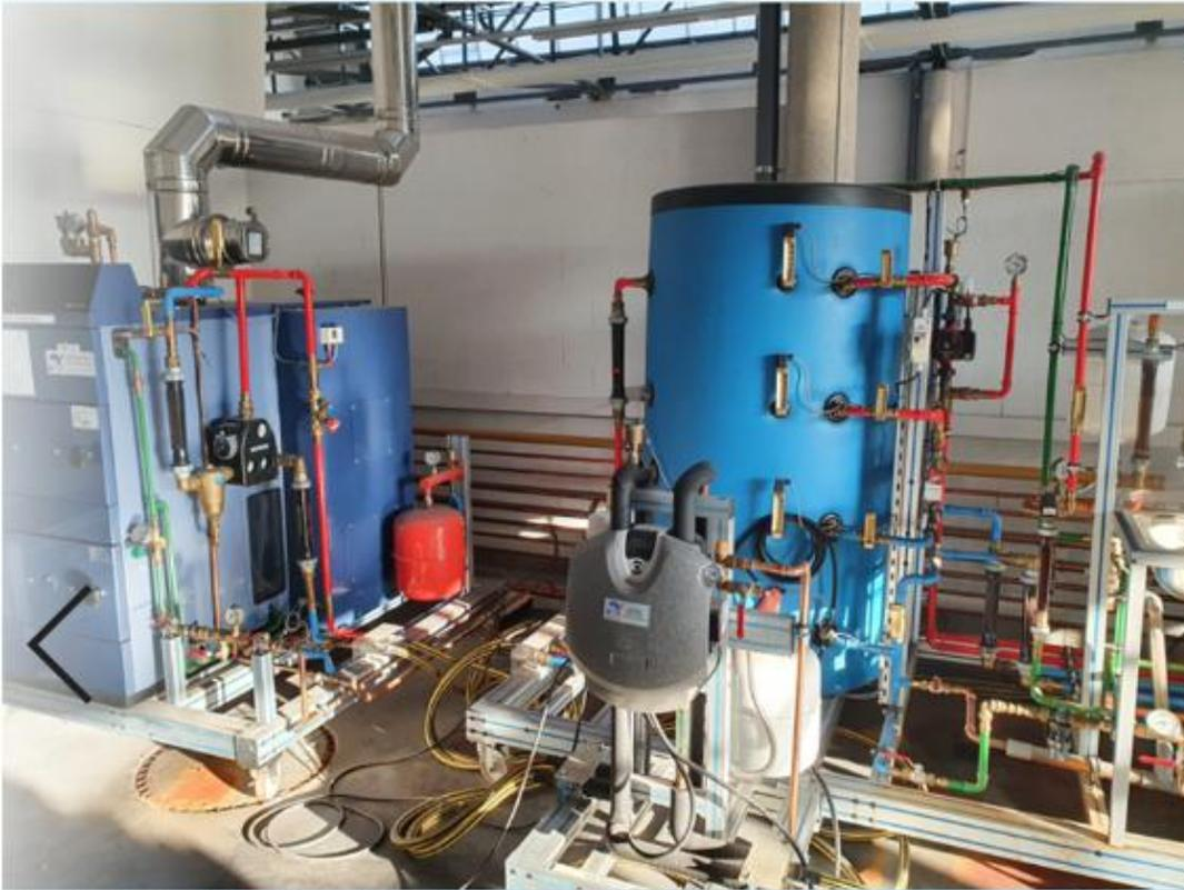
Banc chaudière bois et son ballon de stockage pour l'eau de chauffage et pour la production d'eau chaude sanitaire avec appoint solaire.
